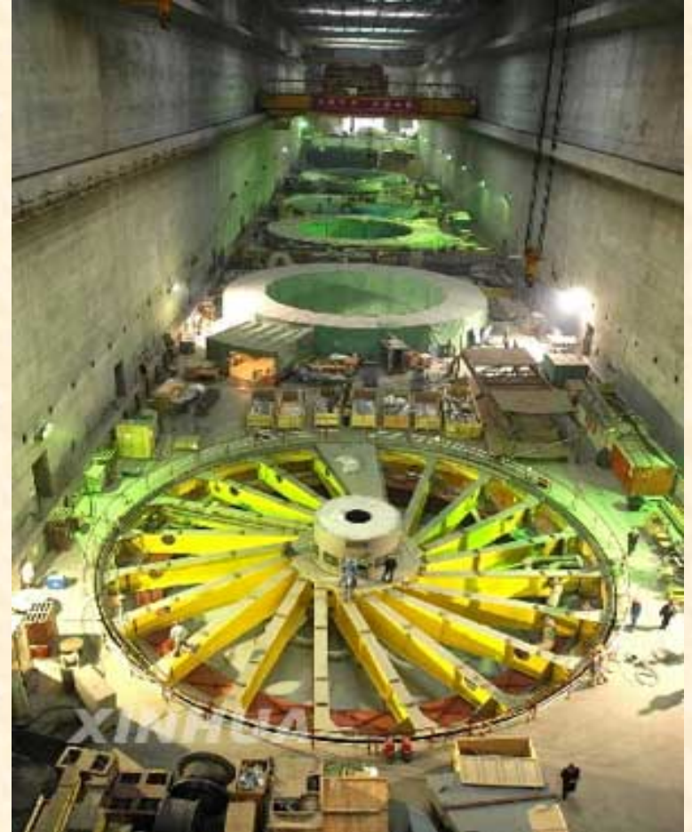
三峡水轮发电机组施工现场
