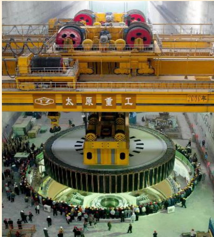
水轮发电机转子吊装
