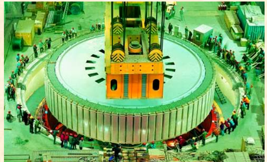
水轮发电机转子装配
