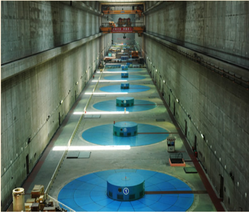
三峡左岸电站厂房内景
