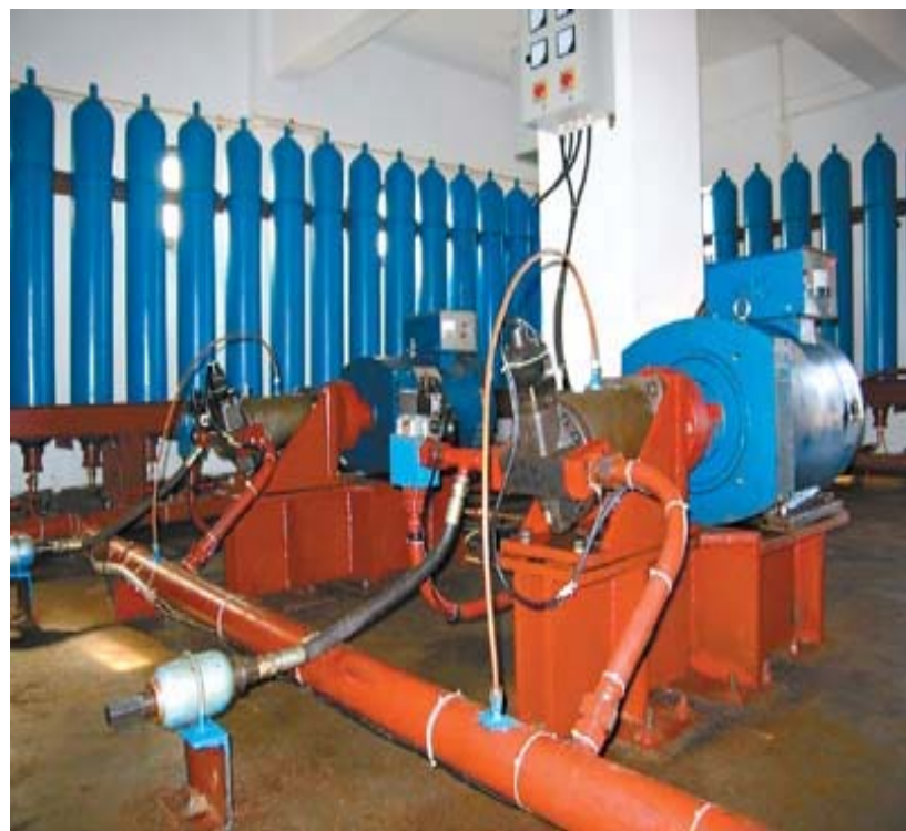
波浪能电站内景
