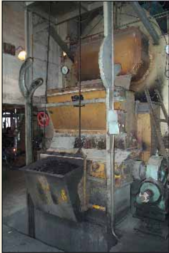
KZL4锅炉输送机(提升机)提升固体燃料
